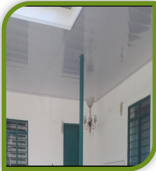
REPARACIONES CIELO FALSO SEDE FUNDACIÓN
